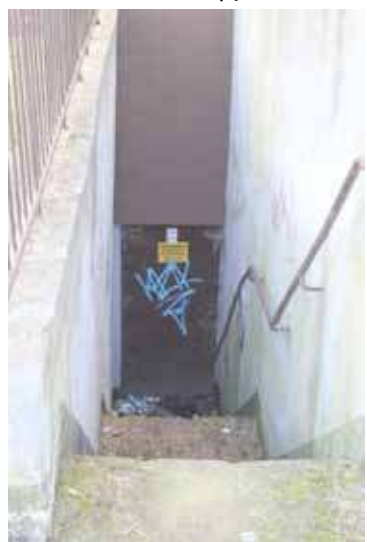
Wejście do nieeksploatowanej już kotłowni węglowej
