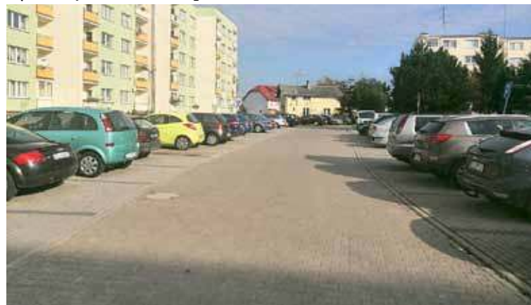
A to już wyremontowana wcześniej droga osiedlowa, od strony ul. Boh. Warszawy wraz z parkingami i nowymi chodnikami
