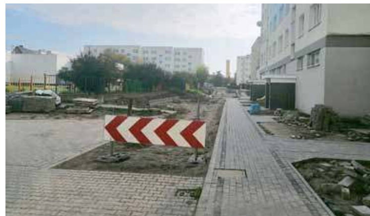
Fragment remontowanej drogi oczywiście jest zamknięty dla ruchu
