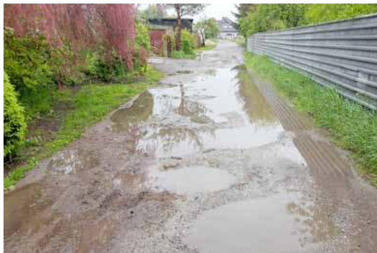
Tak ul. Sikorskiego wygląda po opadach deszczu, do tego po zmroku jest tu ciemno, skarżą się mieszkańcy
