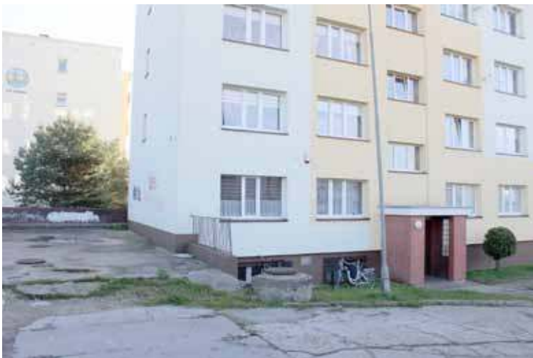
Mieszkańcy skarżą się na uciążliwy hałas powodowany pracą urządzeń w piwnicy
