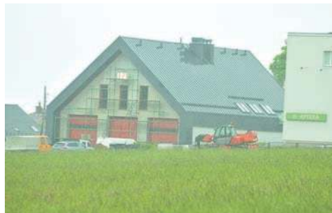
Nowa remiza przy Sobieskiego w Plazie
