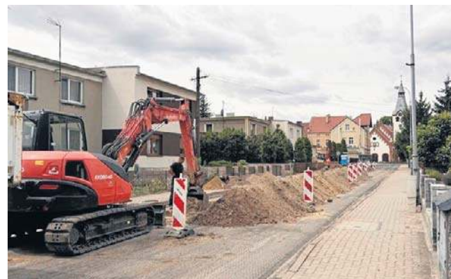
Inwestycja obejmuje całą ul. Barteckiego oraz część ul. Marii Skłodowskiej-Curie
