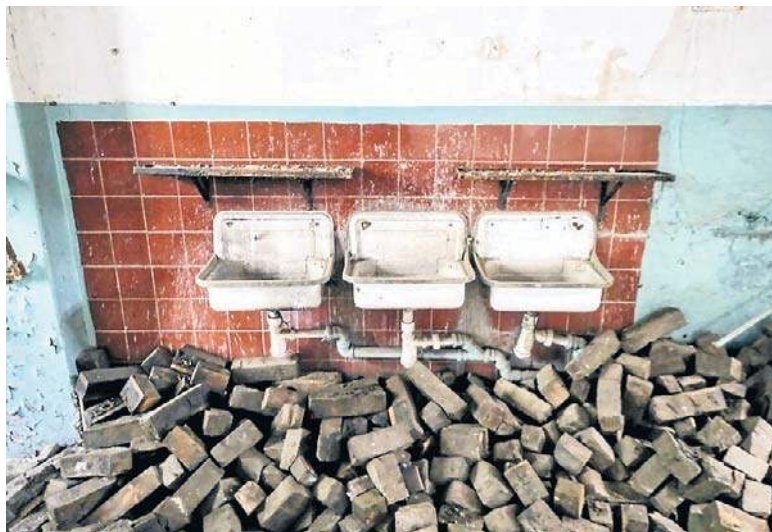
Pozwolenie na prace w zajezdni musi wydać konserwator zabytków
