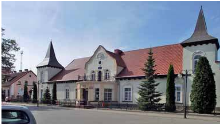
Człuchów. Budynek dawnej poczty
