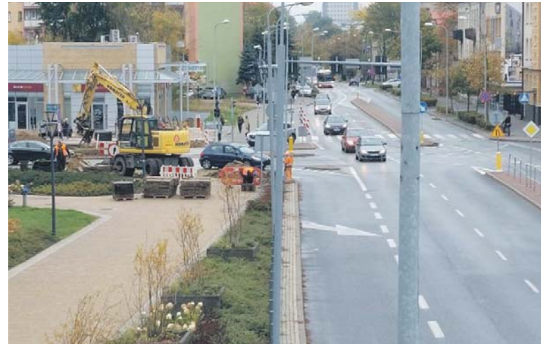
Prace przy budowie przejścia dla pieszych przez ulicę Struga na plac Jagielloński trwają już od kilku dni.
