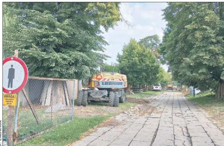
Trwa przebudowa al. Spacerowej
