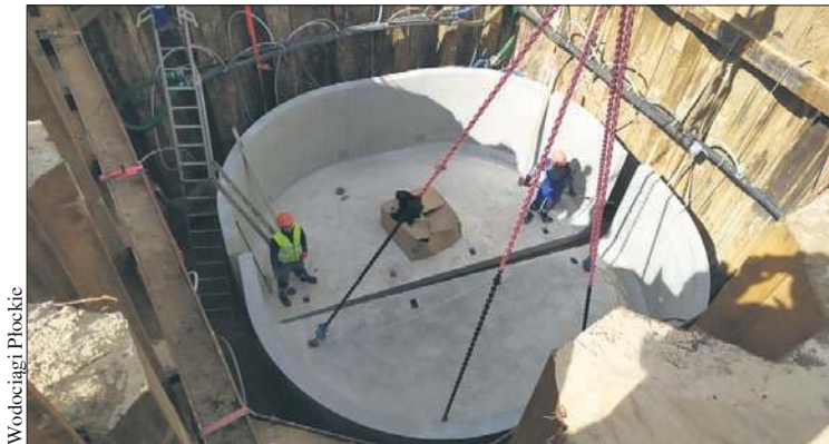
W Borowiczkach trwa przebudowa przepompowni ścieków
