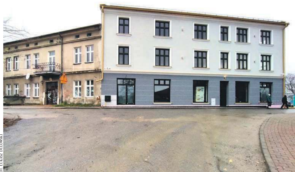
Prywatne kamienice przy Zielonej 5 i 7 w Chrzanowie
