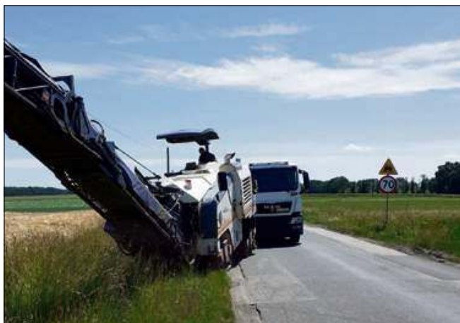
Łącznie wyremontowano 2 km nawierzchni.
