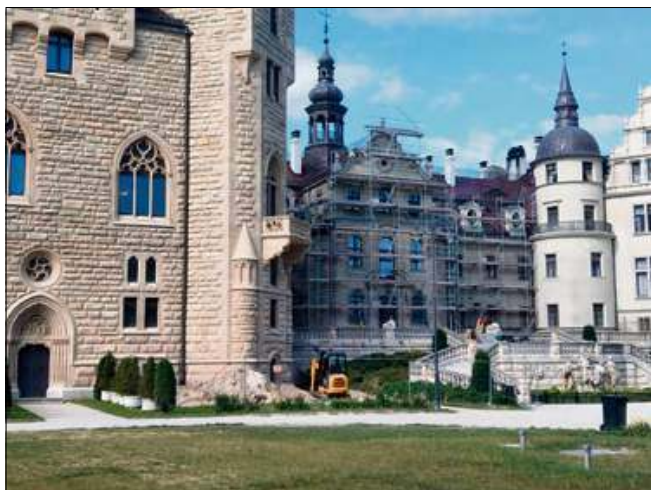
Prace związane z rewitalizacją elewacji zamku wielkimi krokami zmierzają do finiszu.
