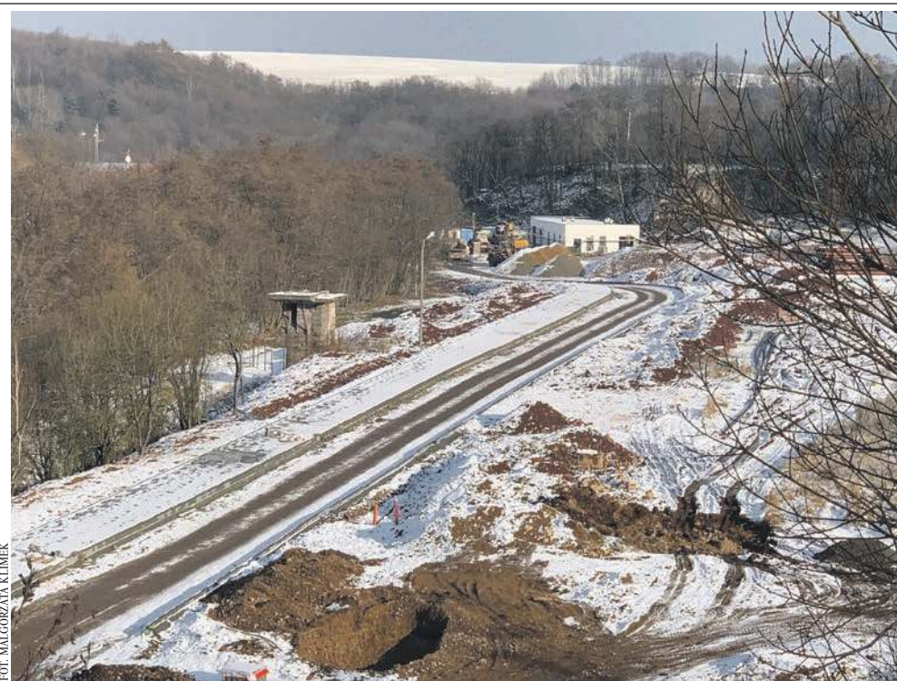
Widok na Strefę Aktywności Gospodarczej powstającą w Miękinii
