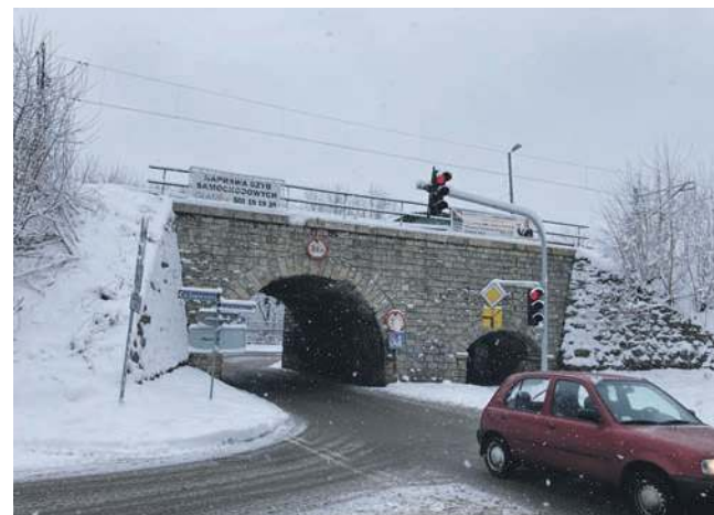
Wiadukt na ul. Siennej
