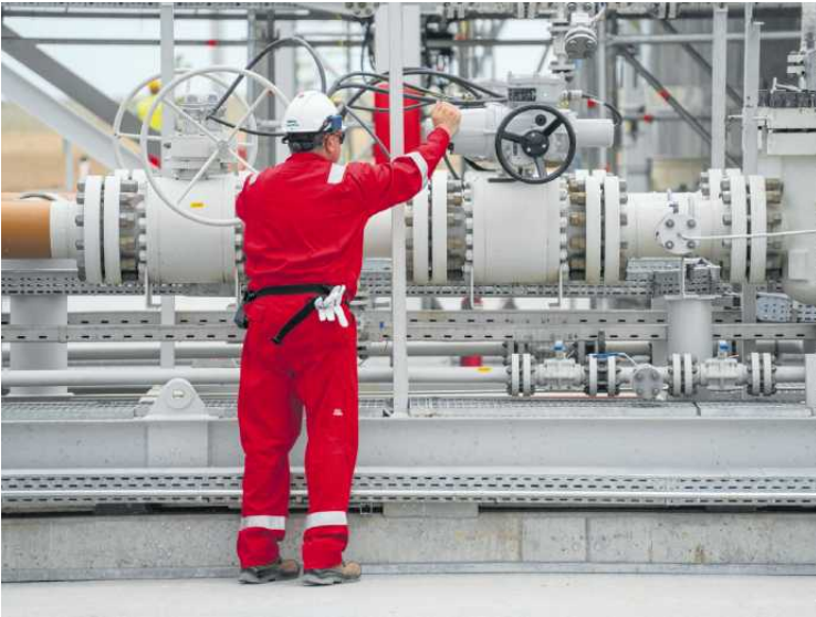
• Vadu, Rumunia, 28 czerwca 2022 r. Otwarcie zakładu przetwarzania gazu wykorzystującego zasoby z Morza Czarnego
