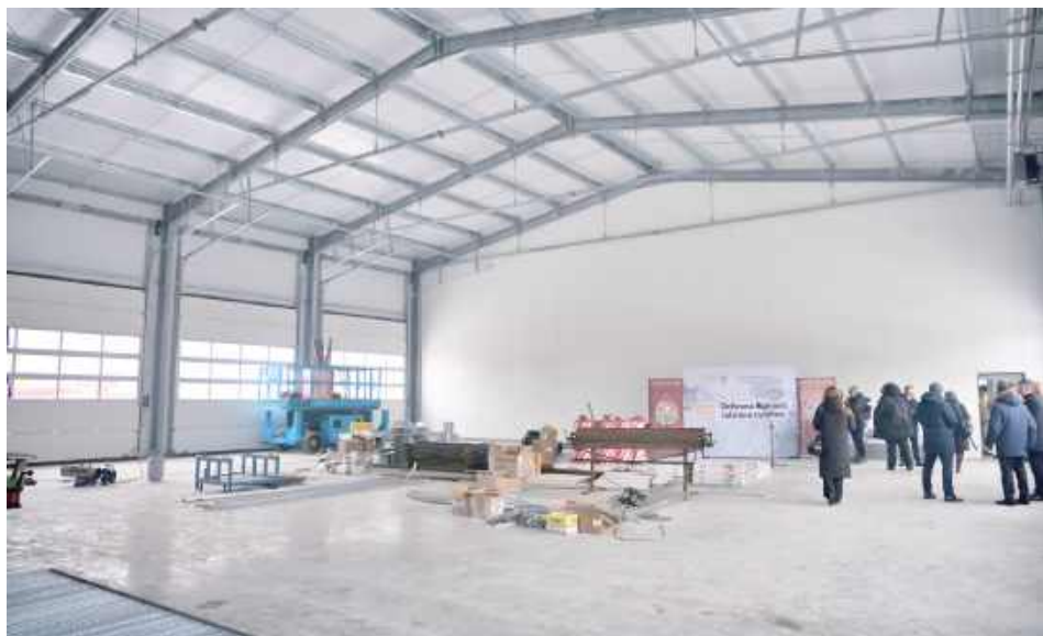
Budynek ma powierzchnię blisko 1000 mkw, a jego całkowity koszt wyniósł 4,5 mln zł
