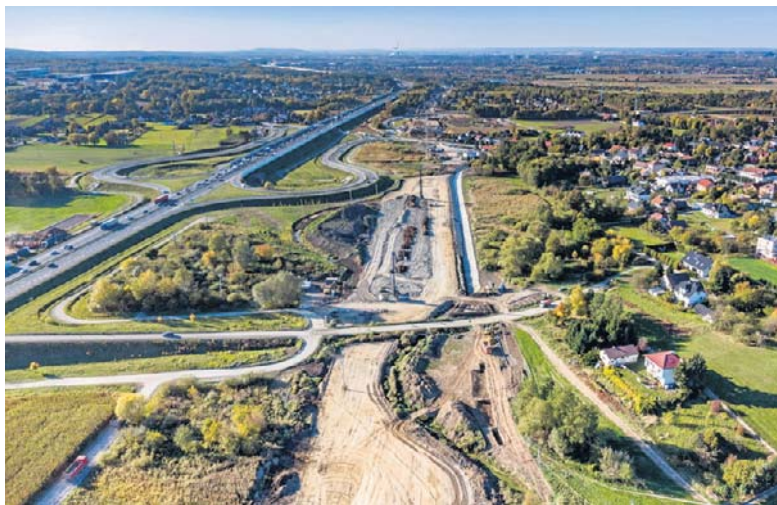
Budowa nowej linii kolejowej pod Krakowem idzie pełną parą
