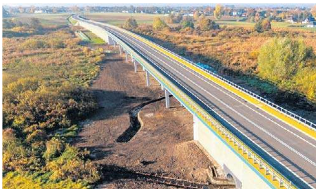
W ramach zrealizowanej właśnie inwestycji powstała m.in. estakada nad rzeką Panną o długości 220 metrów
