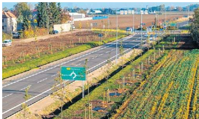
Oddany do użytku drugi odcinek mogileńskiej obwodnicy łączy rondo w Świerkówcie z Żabnem
