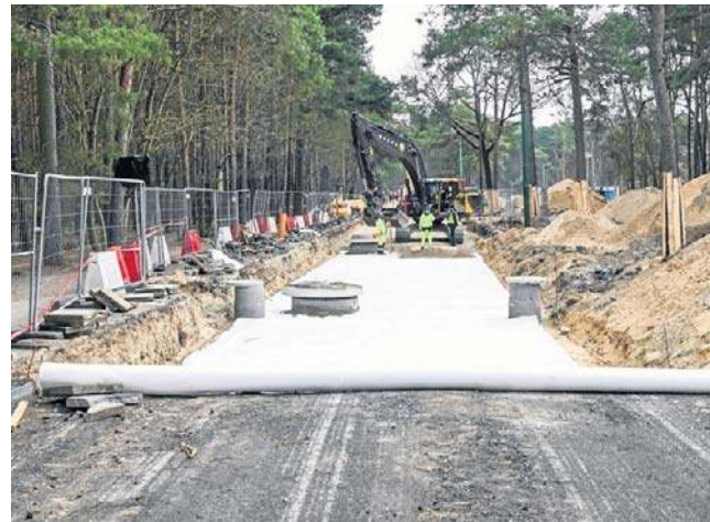
Prace na pętli Las Gdański rozpoczęły się na początku roku
