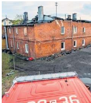
Budynek nie nadaje się do zamieszkania
