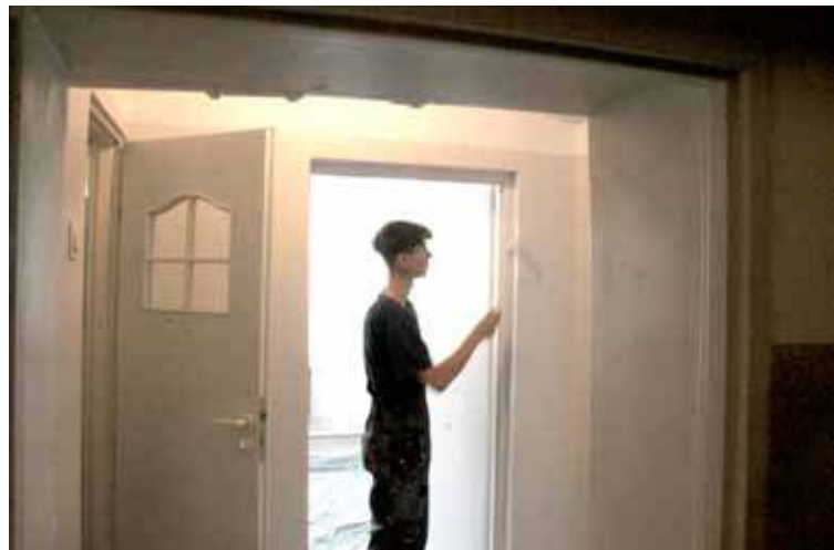
Cały budynek szkoły jest poddawany gruntownemu remontowi - czyli od piwnicy do drugiego piętra
