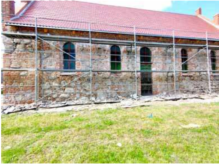
Gmina otrzyma 30.000 zł dofinansowania na remont elewacji ściany bocznej kościoła w Krzywnicy. Foto. Iwona Jeszke
