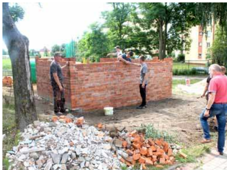
Uczniowie wraz z nauczycielem zawodu budują wiatę śmietnikową przy budynku szkoły
