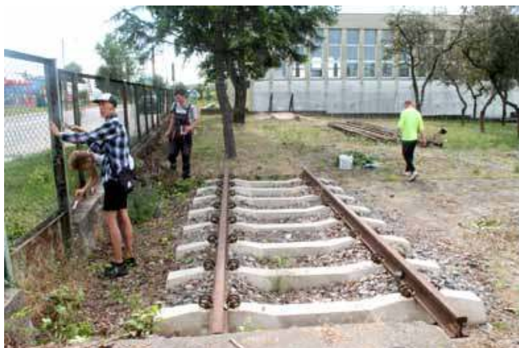
Uczniowie odnawiają ogrodzenie. Zostały już też ustawione tory, które będą służyły uczącym się budownictwa kolejowego
