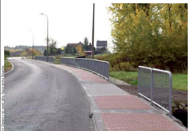
Firma z Adamowa w bardzo szybkim tempie uporała się z pracami budowy chodnika na ul. Czołnowskiej w Baranowie
