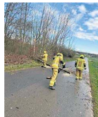
Drzewo powalone na drogę w Jankowicach
