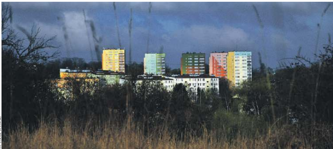
FOT. LUKASZ DULOWSKI Bloki na osiedlu Północ w Chrzanowie
