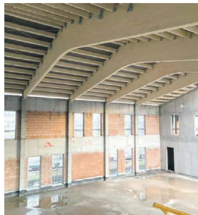
Wnętrze nowej sali gimnastycznej przy LO w Krzeszowicach
