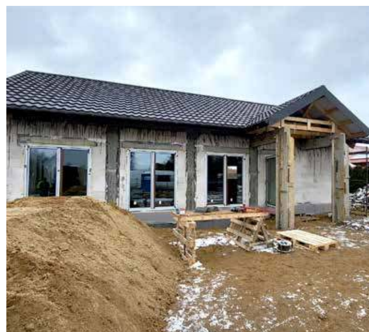
Zakończył się pierwszy etap budowy świetlic w miejscowości Bytowo, Lutkowo i Sierakowo
