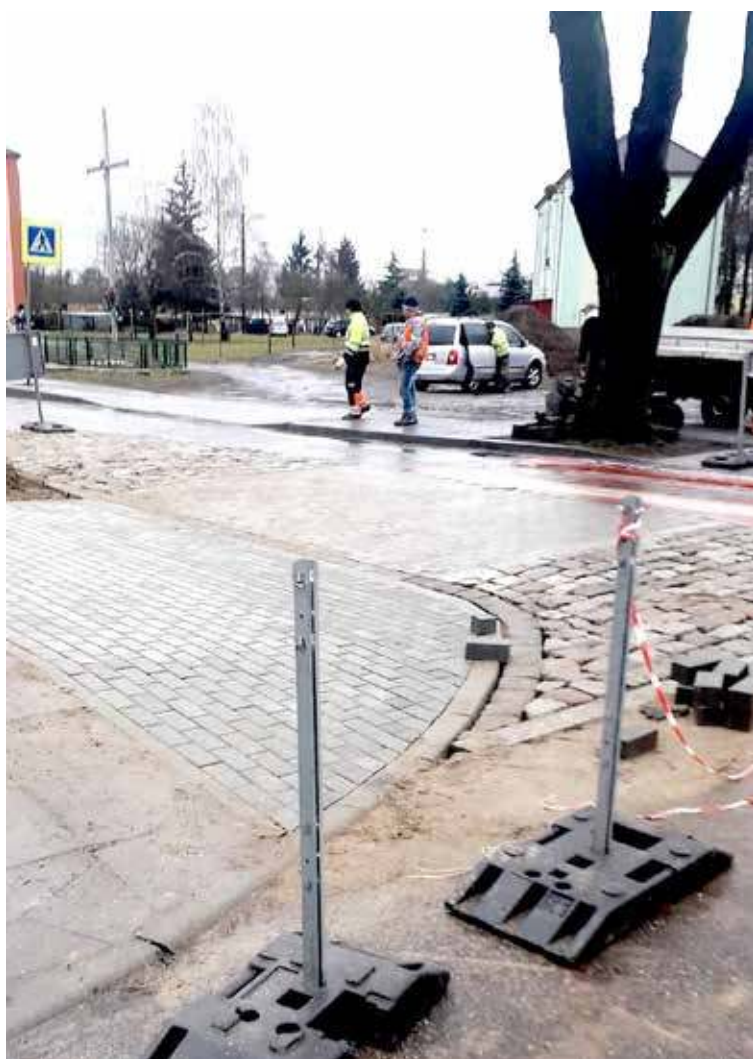
Przejście dla pieszych na ulicy Traugutta zostanie wyniesione. Dzięki temu zwiększy się bezpieczeństwo pieszych.
