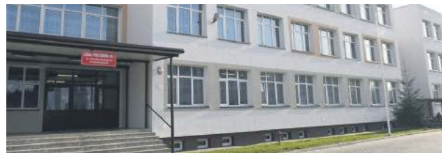
Budynek szkoły po remoncie. Fot. nadesłane
