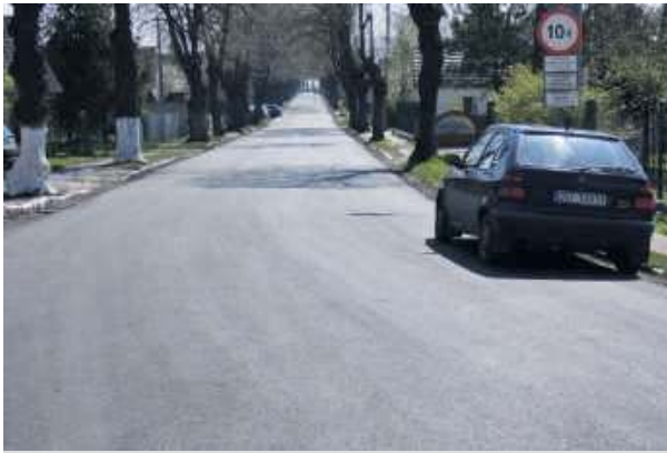
Czy to już koniec remontu drogi w Starym Wiązowie?
