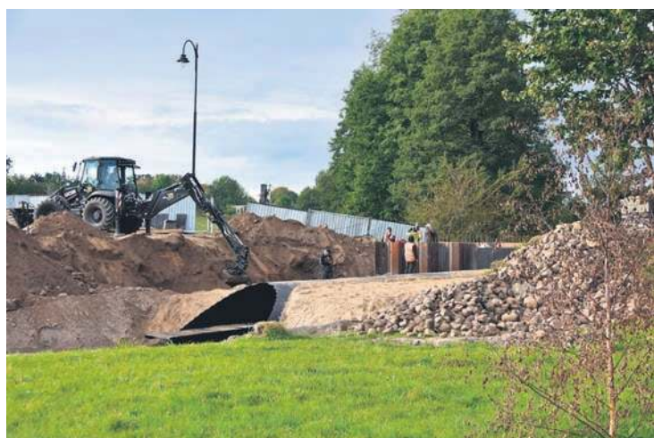
Trwająca inwestycja w Śliwicach radykalnie zmieniła tymczasowy wygląd w obrębie Polany Śliwickiej.
