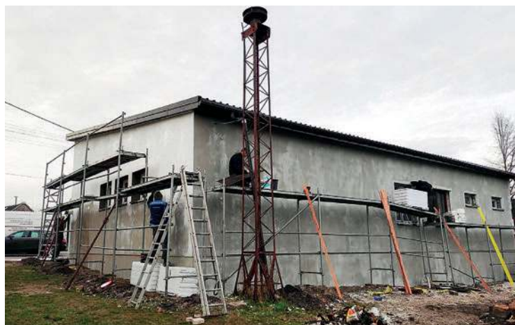
Trwa termomodernizacja świetlicy wiejskiej w Rydzewie; prace podzielono na etapy
