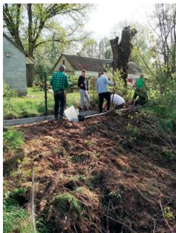
Prace na placu wiejskim w Gładczyń Rządowym – mężczyźni zamontowali ogrodzenie
