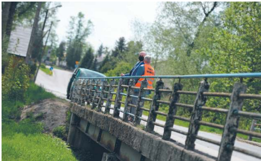
Przebudowa mostu ma ruszyć lada dzień. Będą utrudnienia w ruchu. Na czas remontu wykonawca przygotowuje kładkę dla pieszych, rowerzystów oraz motorowerzystów
