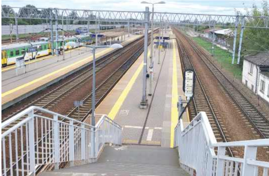
Na stacji Łuków stan schodów i podnośników umożliwia bezpieczne korzystanie oraz zapewnia dostępność dla osób o ograniczonej mobilności - twierdzi spółka PKP PLK S.A.
