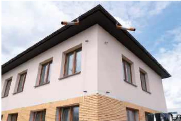
Przy ul. Żelechowskiej w Łukowie trwają prace nad budynkiem mieszkalnym z lokalami socjalnymi
