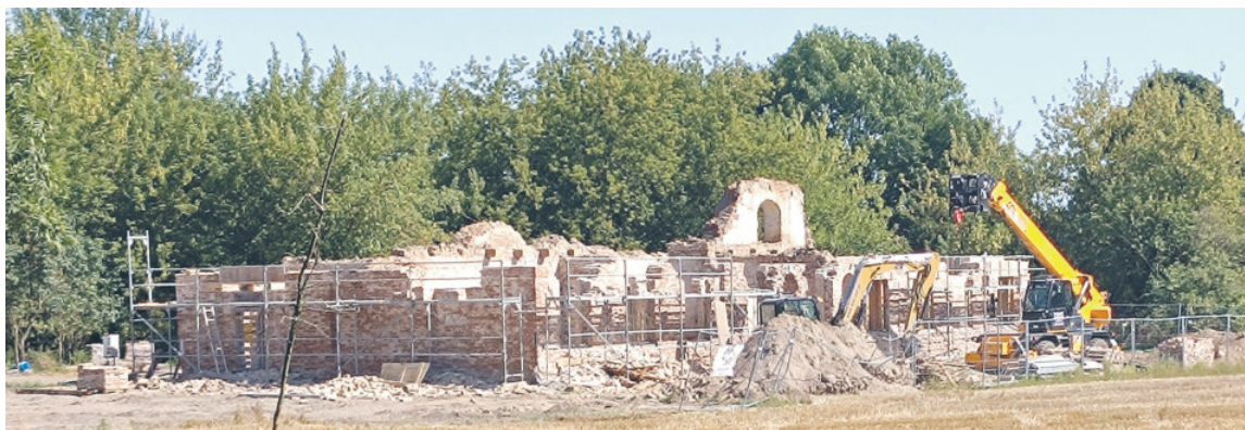
Trwa remont dworu w Iganiach.
