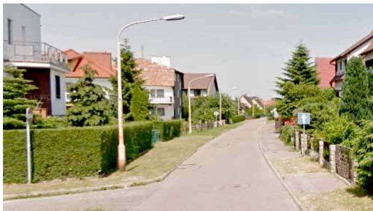
Naprawy lamp będą mogły zostać wykonane dopiero po podpisaniu umowy na konserwację sieci
