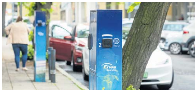
Stacje ładowania pojazdów elektrycznych przy ulicy Konarskiego w Bydgoszczy
