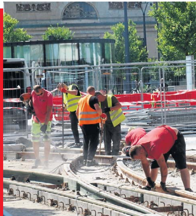
Beton ma być trwalszym rozwiązaniem i lepiej znosić obciążenia niż zastosowana wcześniej kostka.
