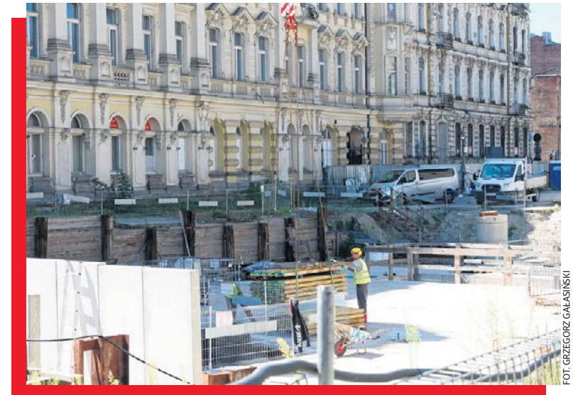
Trwają prace nad przywróceniem przynajmniej częściowej przejezdności skrzyżowania al. Kościuszki i ul. Zachodniej. Nie będzie jednak możliwości jazdy ul. Zieloną.
