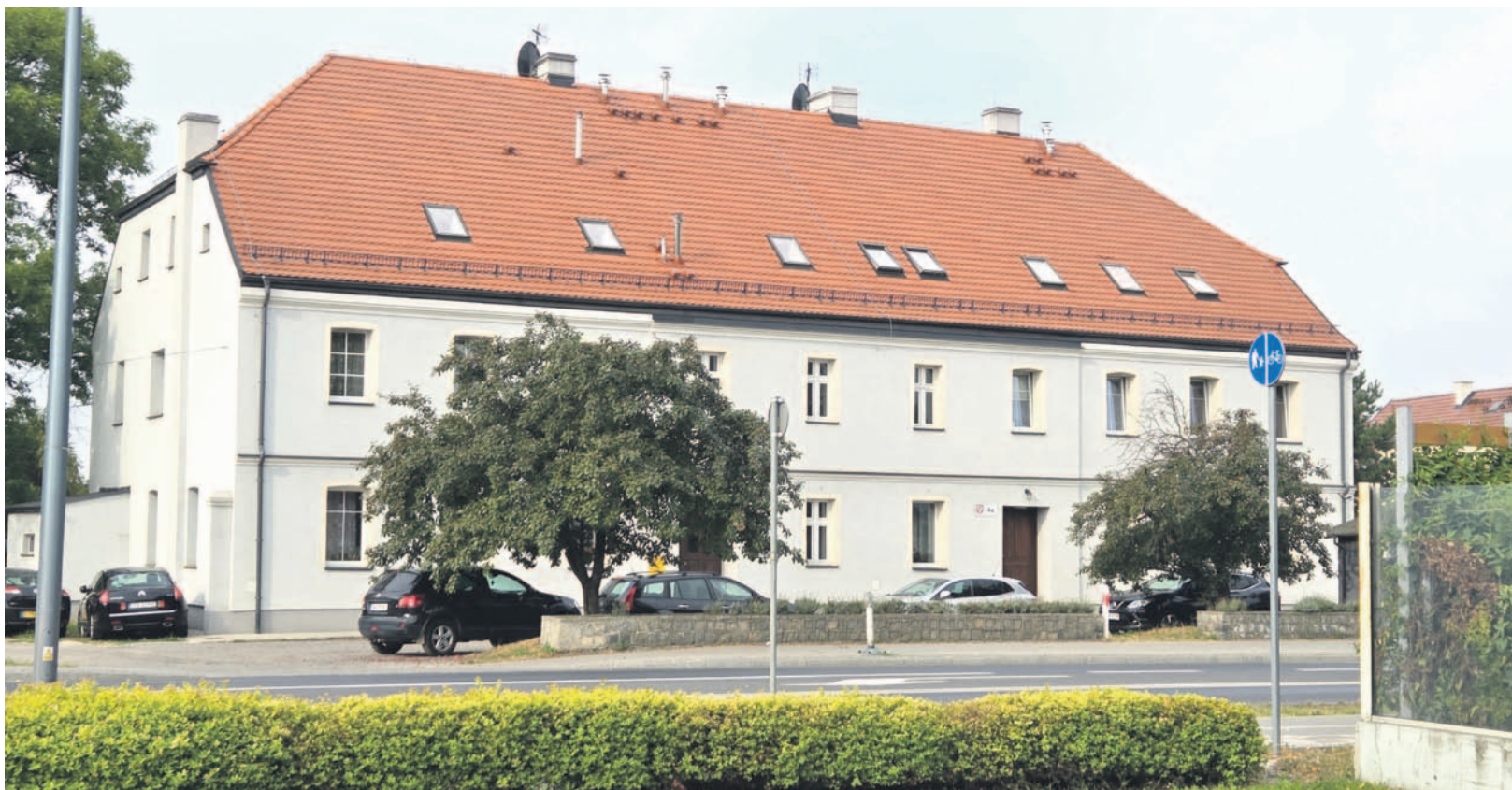
- Dziś budynek przy ul. Kutrowskiego wygląda pięknie, ale jej remont - skutecznie „wyleczył” mnie i moich pracowników z takich prac” - mówi burmistrz
