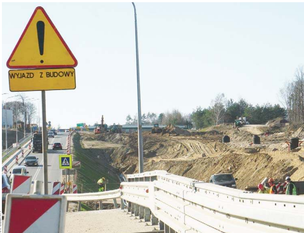
Odcinek S16 Borki Wlk. – Mrągowo ma być gotowy w III kwartale tego roku
