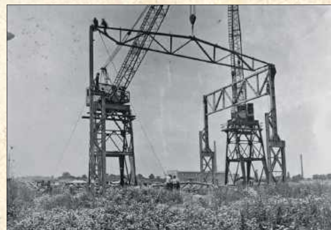
■ Montaż przęsa Hali II
