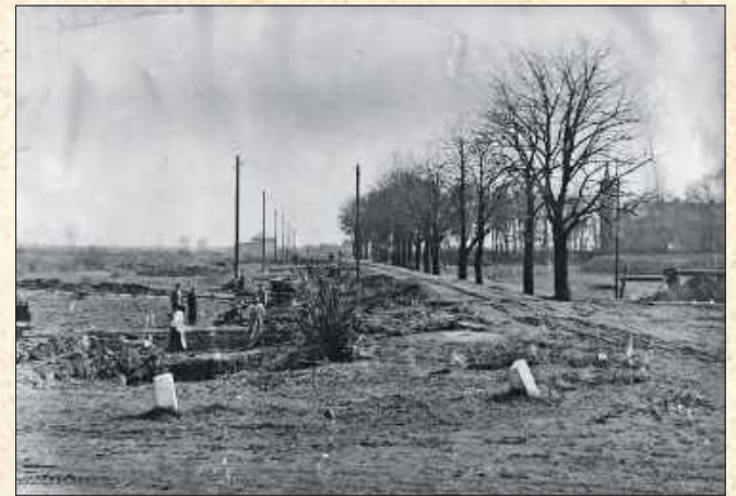
■ Budowa drogi dojazdowej od przejazdu kolejowego do budynku dyrekcji
