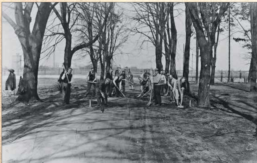
■ 7 kwietnia 1951 rok. Pracownicy biurowi w czynie społecznym porządkują teren dojazdowy do budynku biura dyrekcji.
