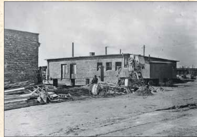
■ Budynki gospodarcze w czasie budowy
