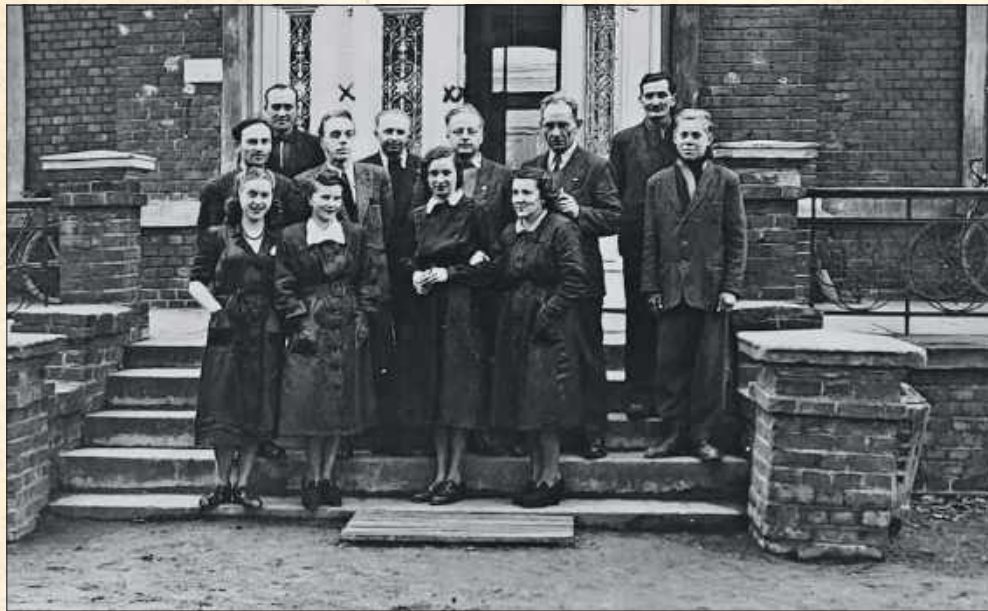
■ Pracownicy Dyrekcji Budowy Fabryki w październiku 1949 roku. Trzeci z lewej dyrektor Mirosław Król, piąty z lewej, pierwszy pracownik Dyrekcji – Błażej Sobczyk.
