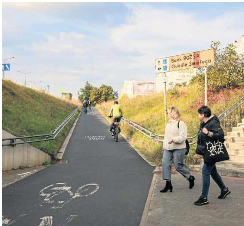
Inwestycje zrealizowane ze środków Poznańskiego Budżetu Obywatelskiego służą poznaniakom na każdym kroku: należą do nich bezpieczne drogi rowerowe i chodniki...
