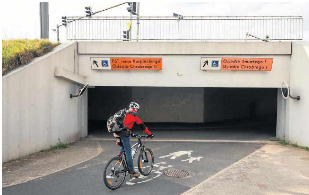
Wygodny zjazd i zejście zarazem służy rowerzystom, pieszym i osobom z niepełnosprawnościami
