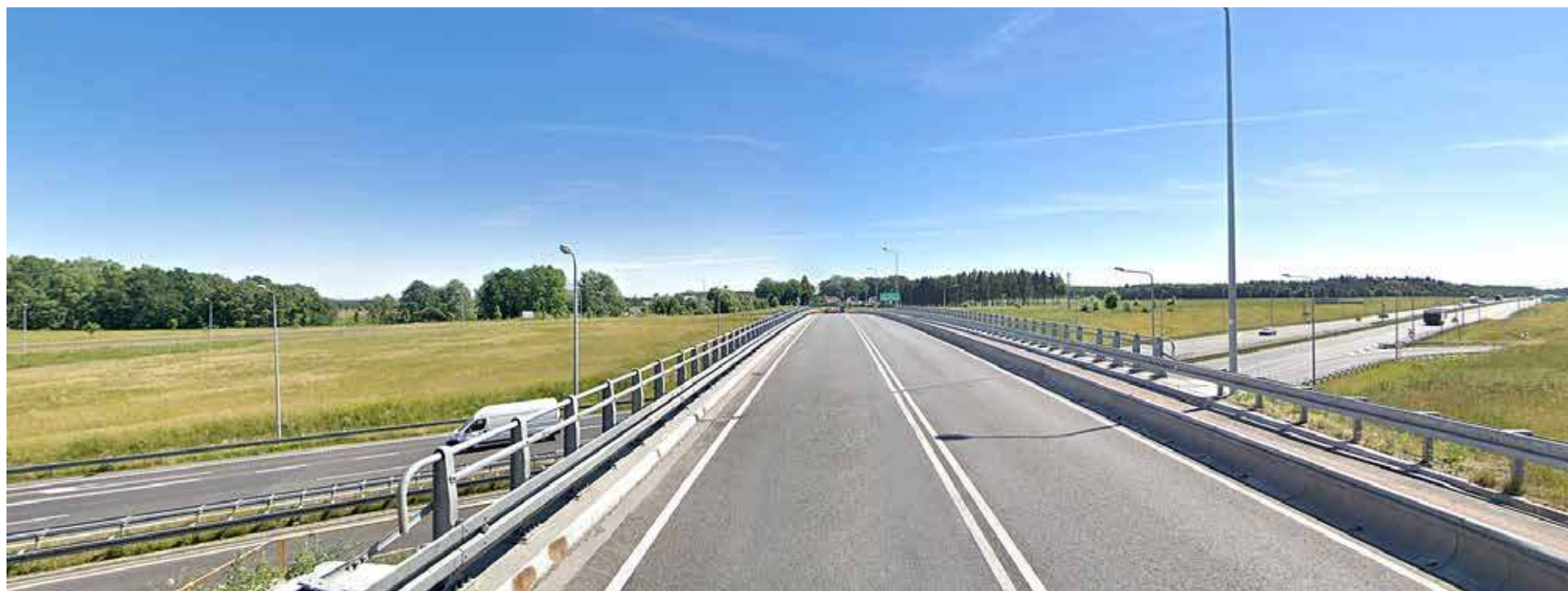
Węzeł Północ - obwodnicy Nowogardu
