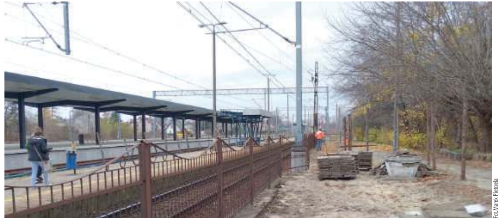
W grudniu 2021 r. wreszcie ma zostać zakończony pierwszy etap modernizacji stacji Białą Podlaska, którego symbolem będzie udostępnienie nowego peronu wyspowego nr 2 w Białej Podlaskiej. W czwartek dwóch robotników kręciło się na białskiej stacji przy zdejmowaniu starych płyt obok dworca
