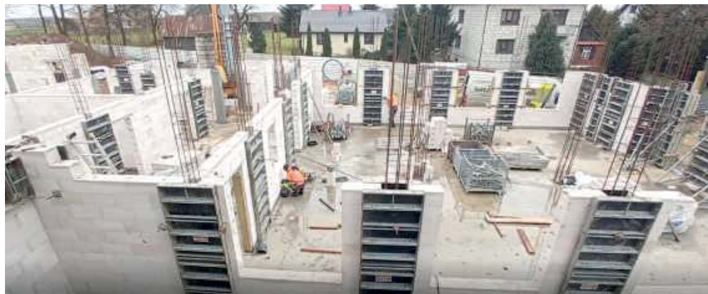
Trwa budowa nowego skrzydła. Koszt zadania to 5,4 mln zł
