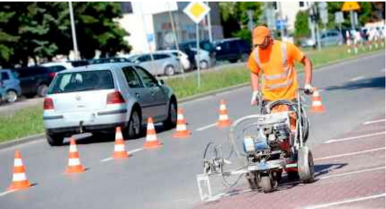
Malowanie pasów na parkingu przy ul. Raclawickiej
