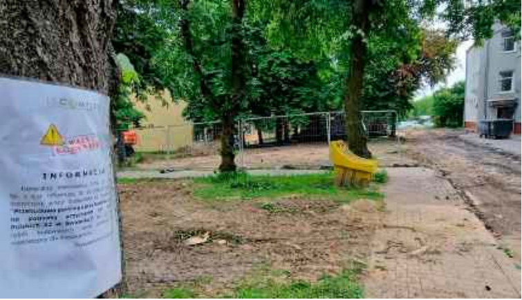
Przebudowa i powiększenie parkingu przy przychodni, zgodnie z umową, potrważą do 5 września
