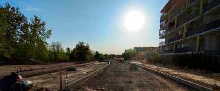
Budowa łącznika już trwa
