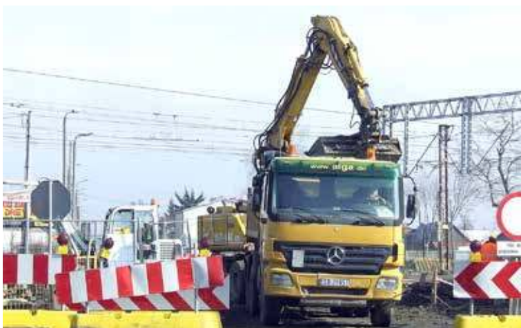
Prace na przejeździe kolejowym w Pilawie
