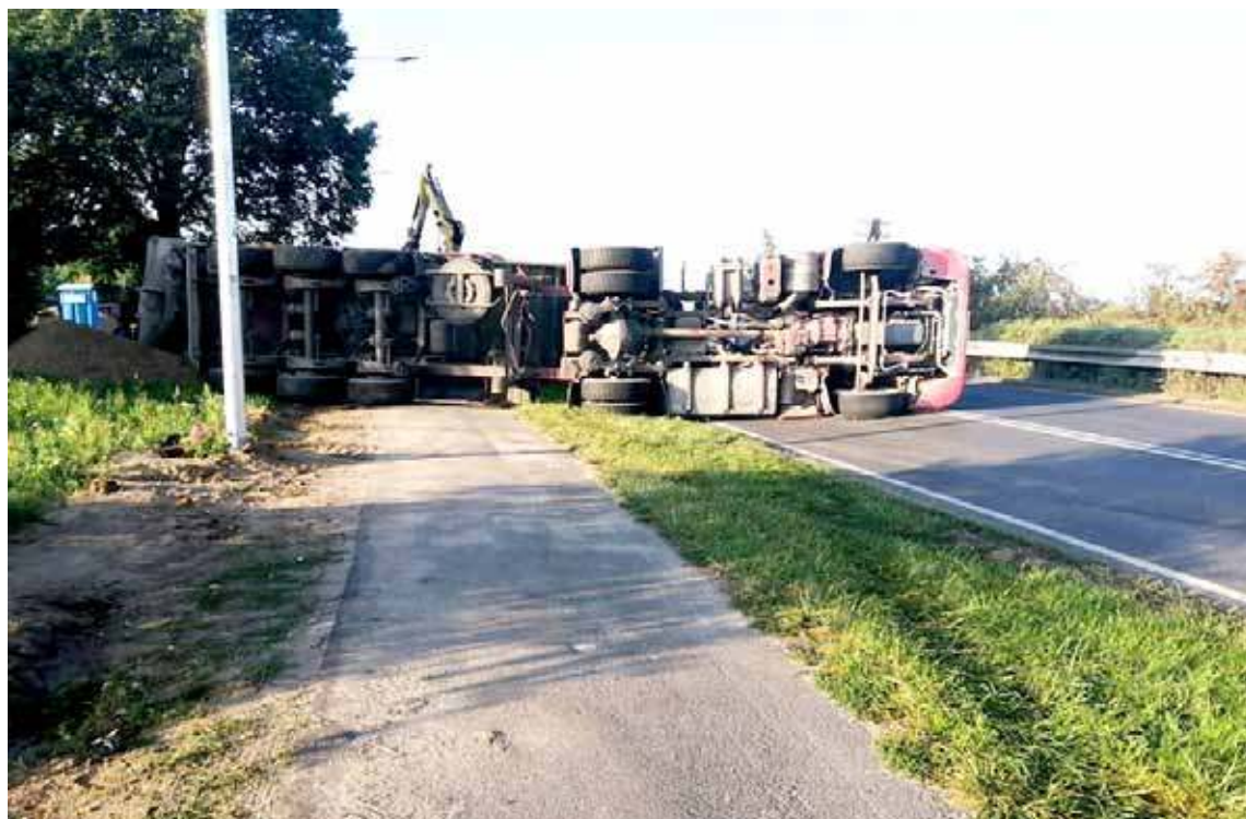
W wyniku zapadnięcia się pobocza na ul. Broniewskiego przewróciła się ciężarówka z kruszywem. Foto. Stojq!Stargard
