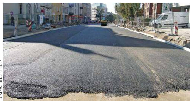
Drogowcy kładą asfalt na kolejnym odcinku ulicy
