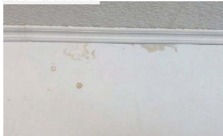
Zacieki na ścianie w mieszkaniu na al. LOP.
