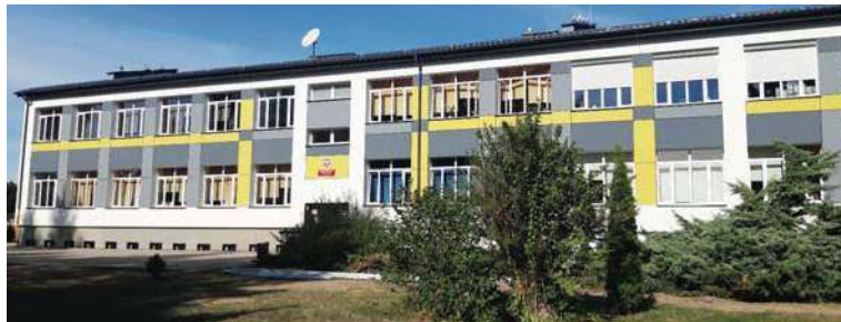
Budynek Szkoły Podstawowej w Kinkajmach po termomodernizacji
