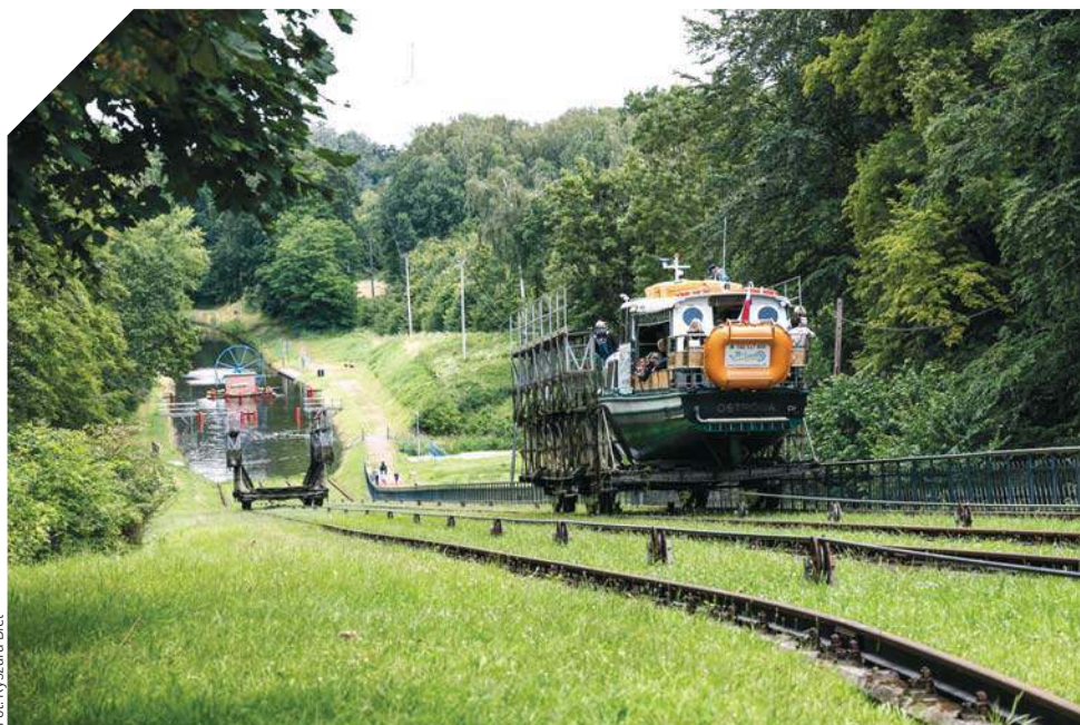
Pochylnia Buczyniec została ukończona w 1860 roku. Na jej wschodnim brzegu znajduje się Muzeum Kanału Elbląskiego
