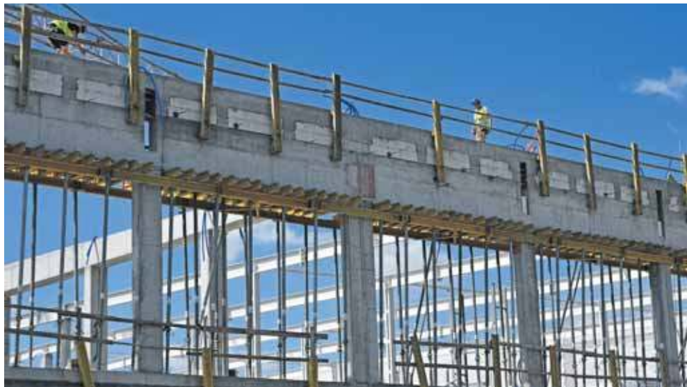
Trwa budowa marketu przy ul. Zagórskiej, inwestorem jest Merkurs Market
