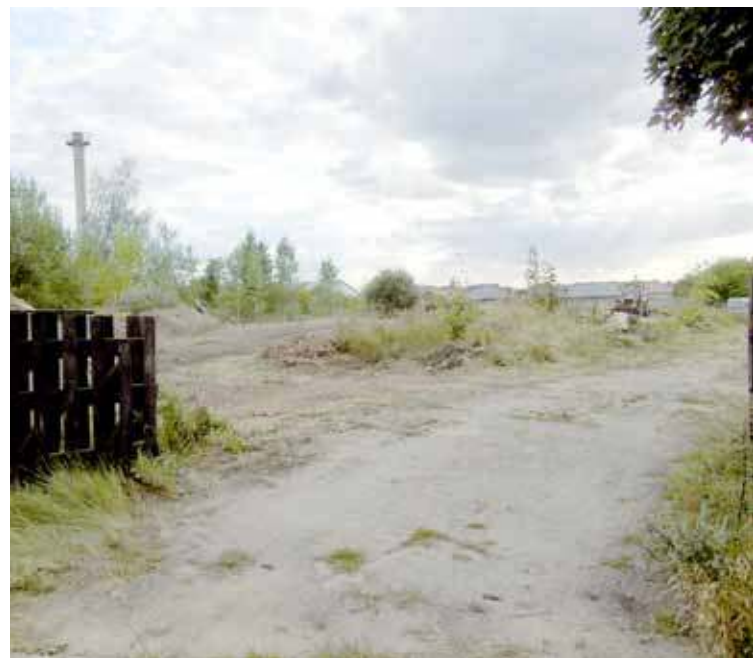
Na terenie po byłej gorzelni nieśmiało rozpoczynają się prace budowlane
