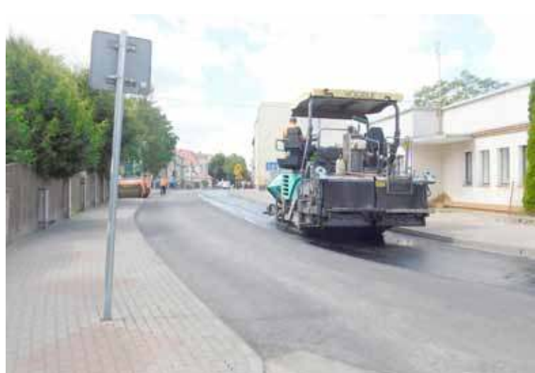
Kontynuacja prac z użyciem ciężkiego sprzętu nastąpiła też w czwartek
