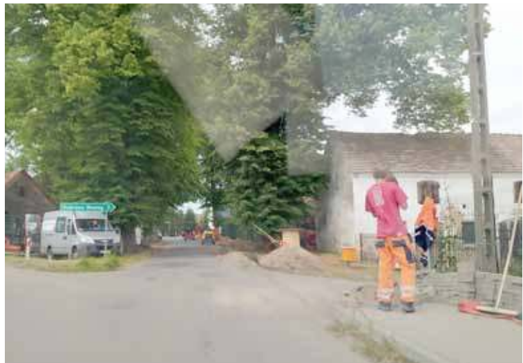
Prace prowadzone w Karsku
