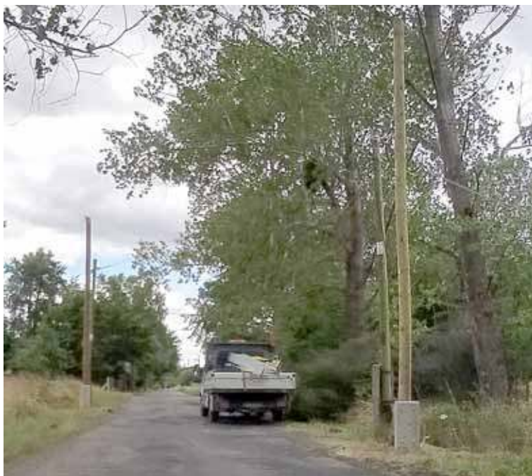
Prace instalacyjne na drewnianych słupach w Bochlinie prowadzone były m.in. w ubiegły czwartek
