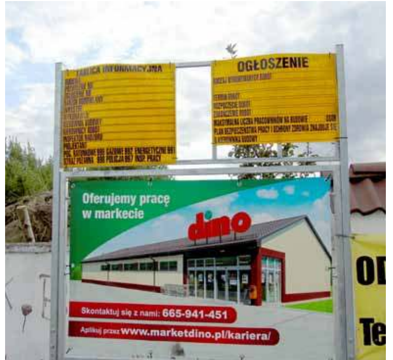
Plac budowy został oznaczony tablicami informacyjnymi
