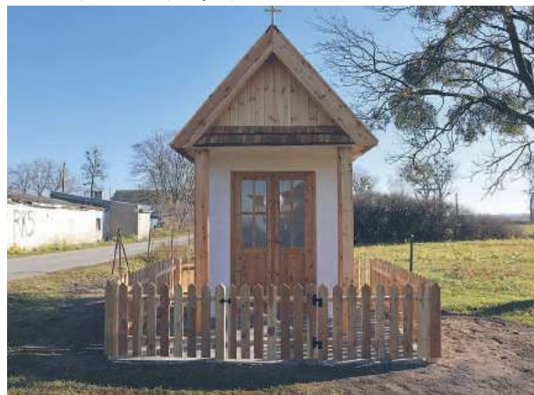
Kapliczka po pracach konserwatorskich w 2021 r.
