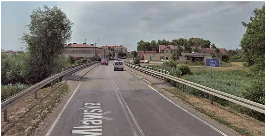
Burmistrz Andrzej Szymański zapewnił, że dopóki nie będzie decyzji, co dalej z przeprawą przez Wkrę, most będzie przejezdny
