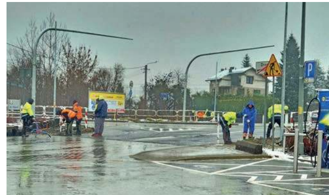
Trwa montaż świateł przy Lidlu
