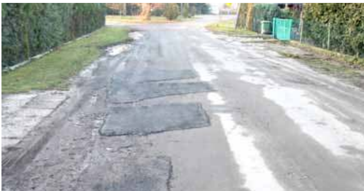
Drogi asfaltowe są łatanie, natomiast gruntowe niwelowane i zwałowane
