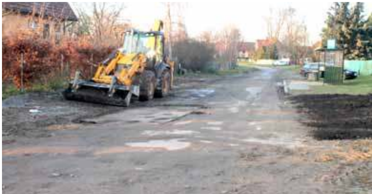
W trakcie prac remontowych w Grzędzicach
