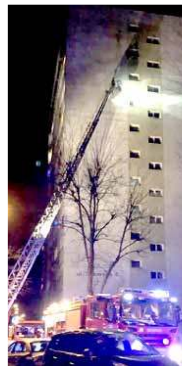
We wtorek 3 grudnia doszło do pożaru zsypana na śmieci w wieżowcu przy ulicy Szewskiej 8. Foto. Stojq!Stargard
