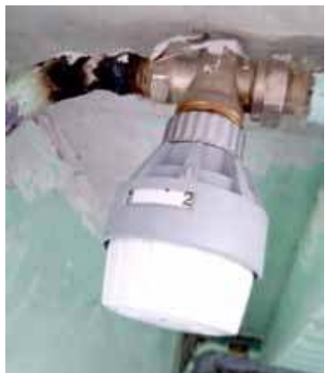
Spółdzielnia zleciła montaż wzmocnionych głowic termozaworów, uniemożliwiające regulowanie wyższych stopni temperatury
