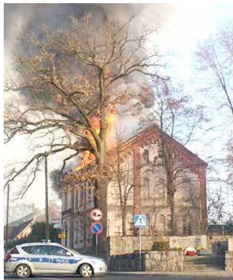
Wczoraj wybuchł pożar w budynku byłej szkoły w Chociwlu. Foto. Stoją!Stargard
