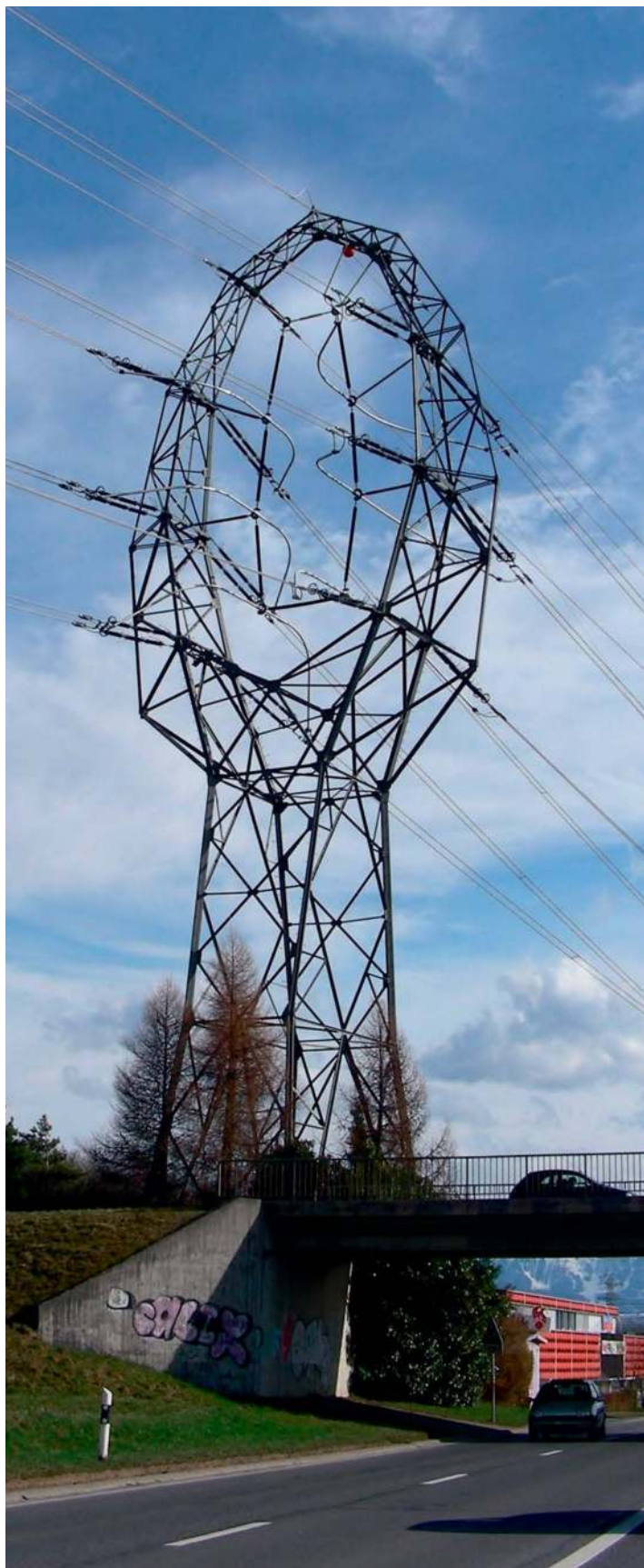
Szwajcaria. Nieco odmienna konstrukcja pylonu
