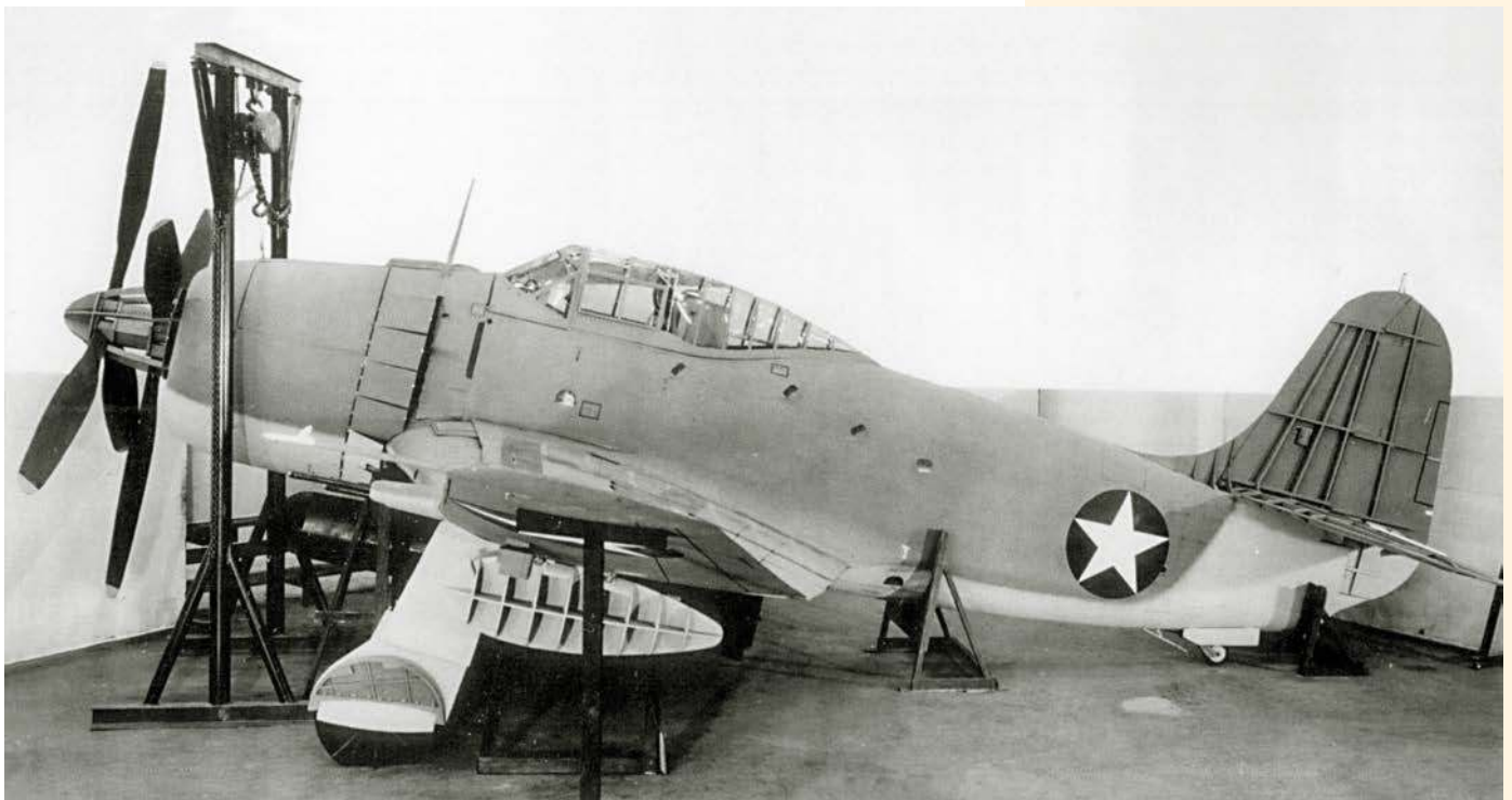
Curtiss przedstawił 15 czerwca 1942 roku projekty wstępne dwóch samolotów – Model 96 z silnikiem R-3350-8 z czterołopatowym śmigłem Curtiss Electric i Model 98 z silnikiem R-4360 z sześciolopatowym śmigłem przeciwbieżnym. BuAer zamówiło budowę dwóch prototypów każdego z nich, nadając im oznaczenia odpowiednio XBTC-1 i XBTC-2. Na zdjęciu: pełnowymiarowa drewniana makieta XBTC-2 w grudniu 1942 roku.
