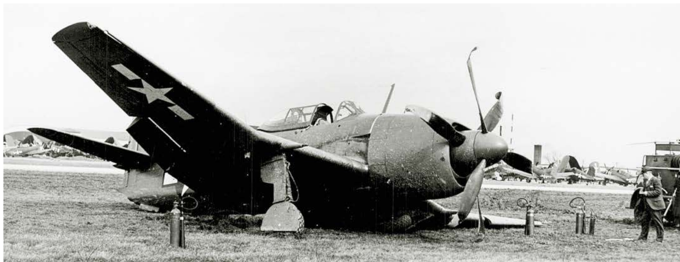
Pierwszy prototyp XBTC-2 (BuNo 31401) został uszkodzony 3 marca 1945 roku, gdy podczas lądowania złożyło się lewe podwozie główne. Prototyp ten był początkowo napędzany silnikiem XR-4360-8A z metalowym sześciopłatowym przeciwbieżnym śmigłem samoprzestawialnym Curtiss Electric z dużym kołpakiem i miał skrzydła Model A.
