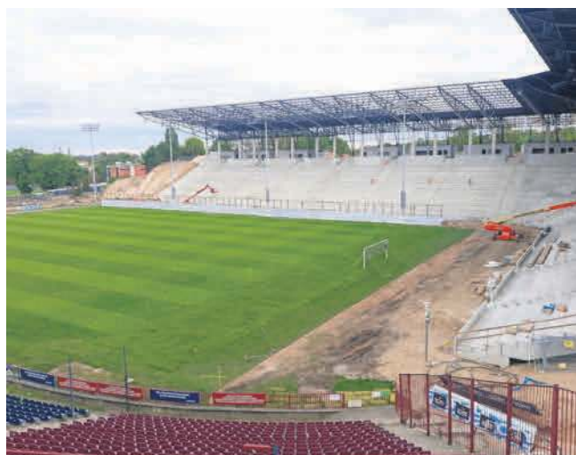
Bramki są już na nowym miejscu, ale docelowo mają zostać przesunięte jeszcze o kilka metrów bliżej trybuny po prawej stronie
